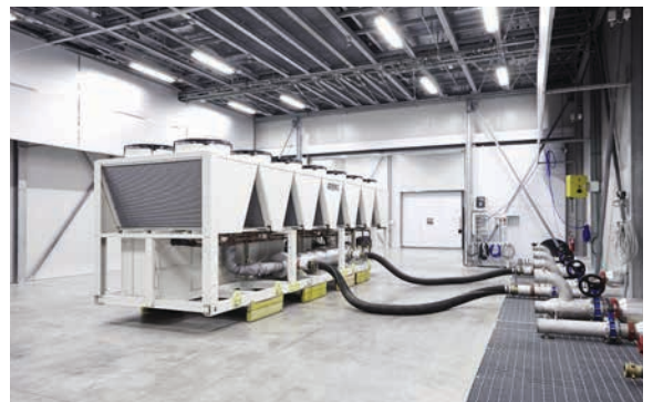
Cámara de pruebas
