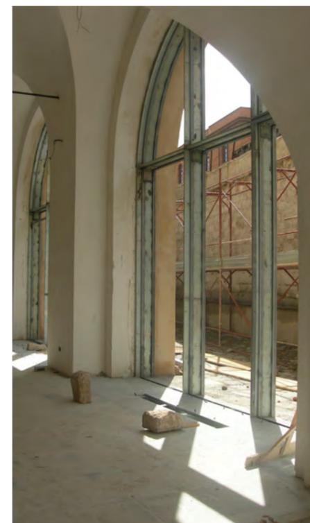
A fianco: a lavori ultimati così si presenta il corridoio che disimpegna le aule del primo piano. Sopra: i telai in acciaio del sistema degli arredi che contiene anche i fancoil a incasso della sala lettura; i telai a sostegno delle vetrate e le mandate d'aria incassate nel pavimento.
