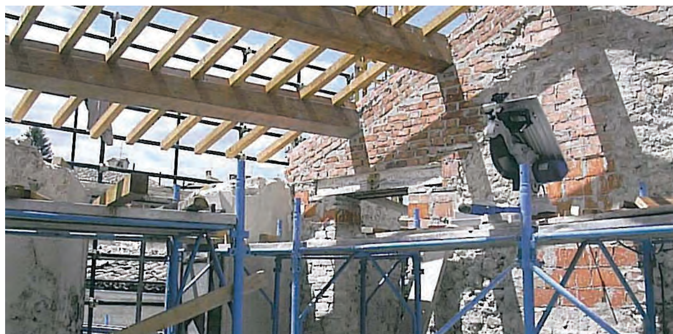
Oltre alle attente valutazioni di stabilità strutturali necessarie per il recupero degli edifici storici per destinazioni diverse da quella originaria, per Palazzo Pianciani vi sono state difficoltà aggiuntive a causa della disomogeneità strutturale tra corpi di fabbrica realizzati in epoche diverse e con materiali diversi.
