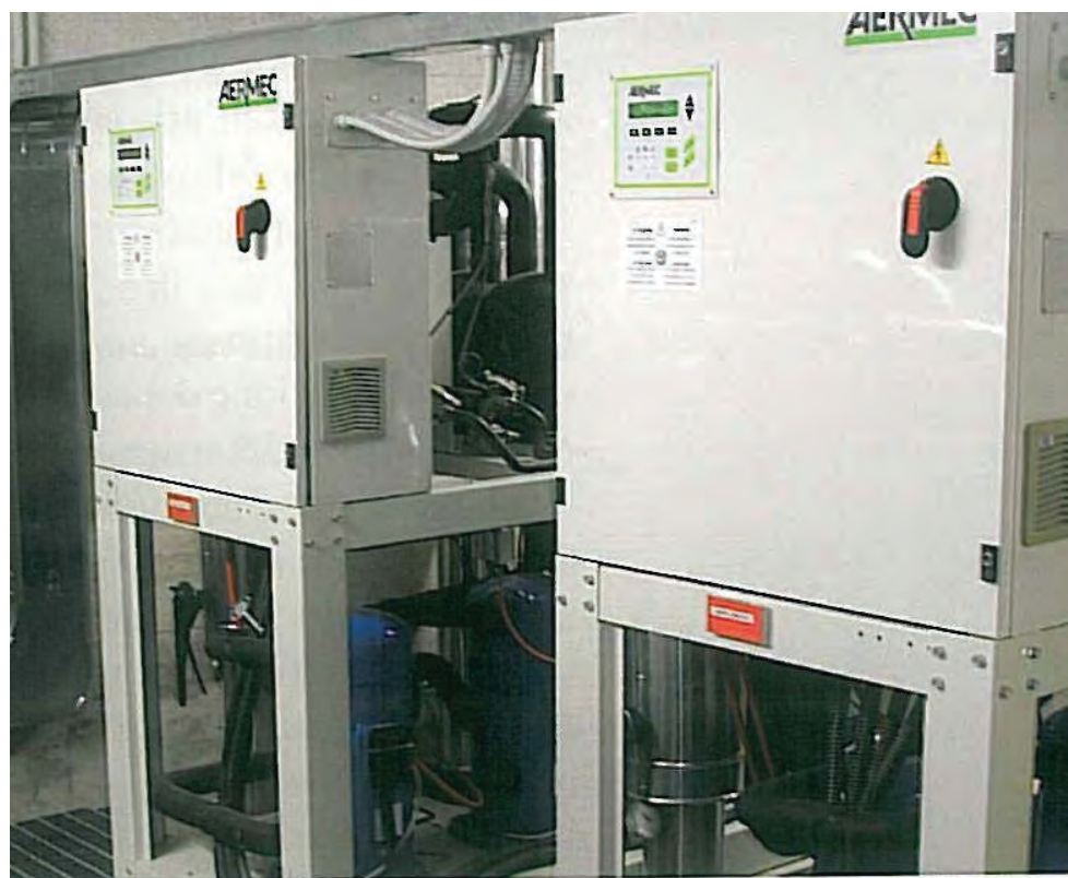
Le centrali termica e frigorifera, nell'impossibilità di usufruire di spazi esterni, sono state posizionate al piano seminterrato in locali appositamente ricavati, con caratteristiche costruttive rispondenti alle normative vigenti per la prevenzione antincendio.
