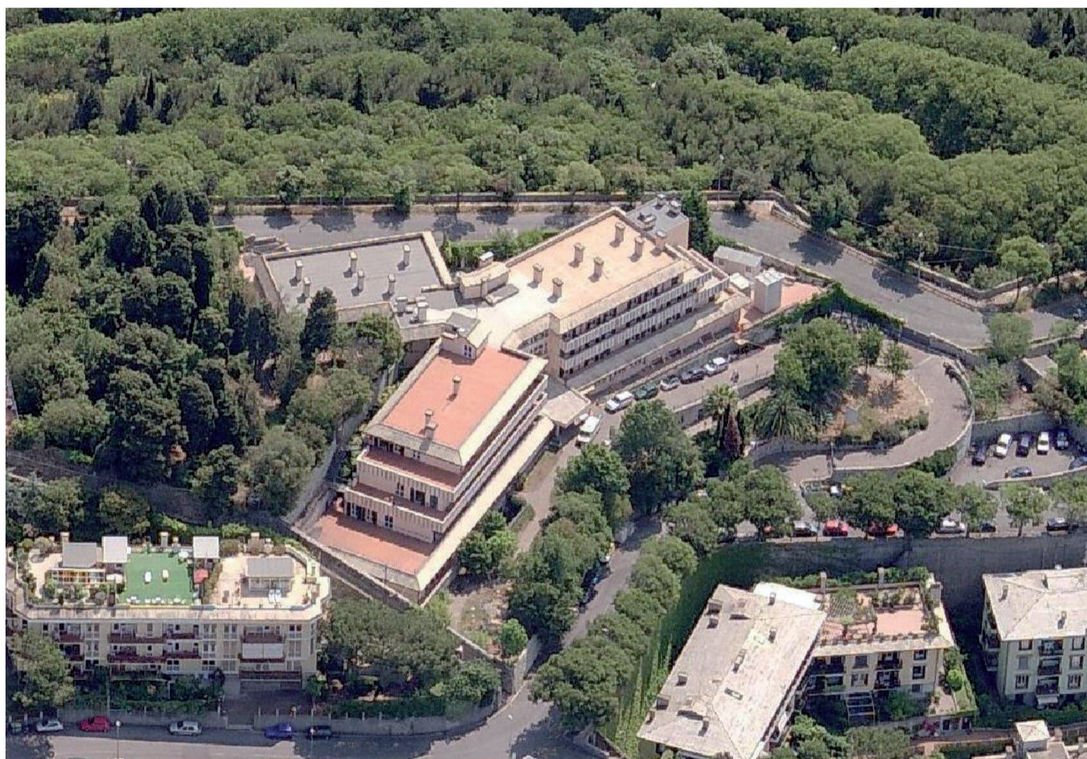
Vista aerea dei tre corpi di fabbrica uniti al centro dall'elemento distributivo. In alto a sinistra con la copertura grigia si vede il corpo oggetto di sopraelevazione ante lavori.
