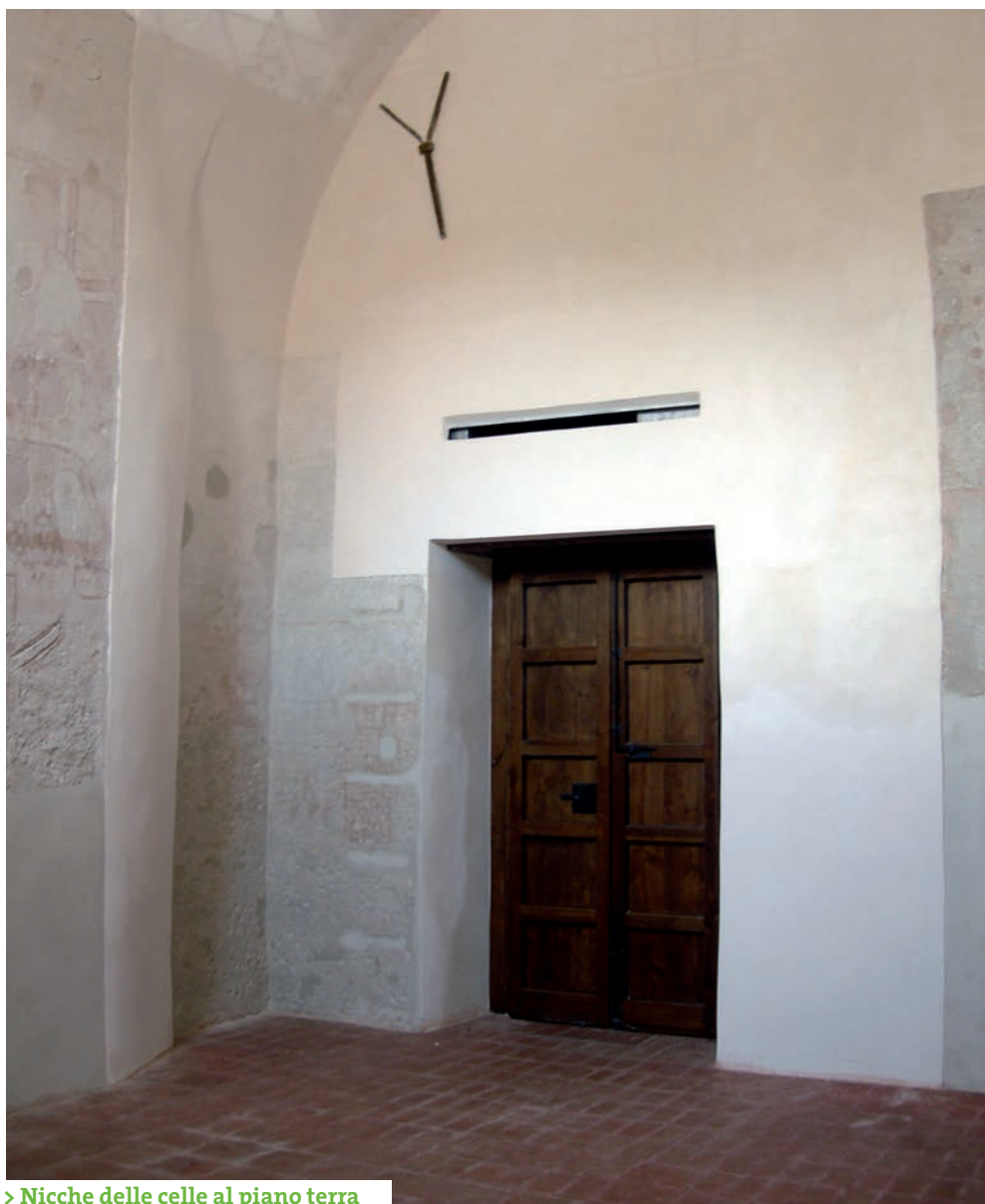
> Nicchie delle celle al piano terra
