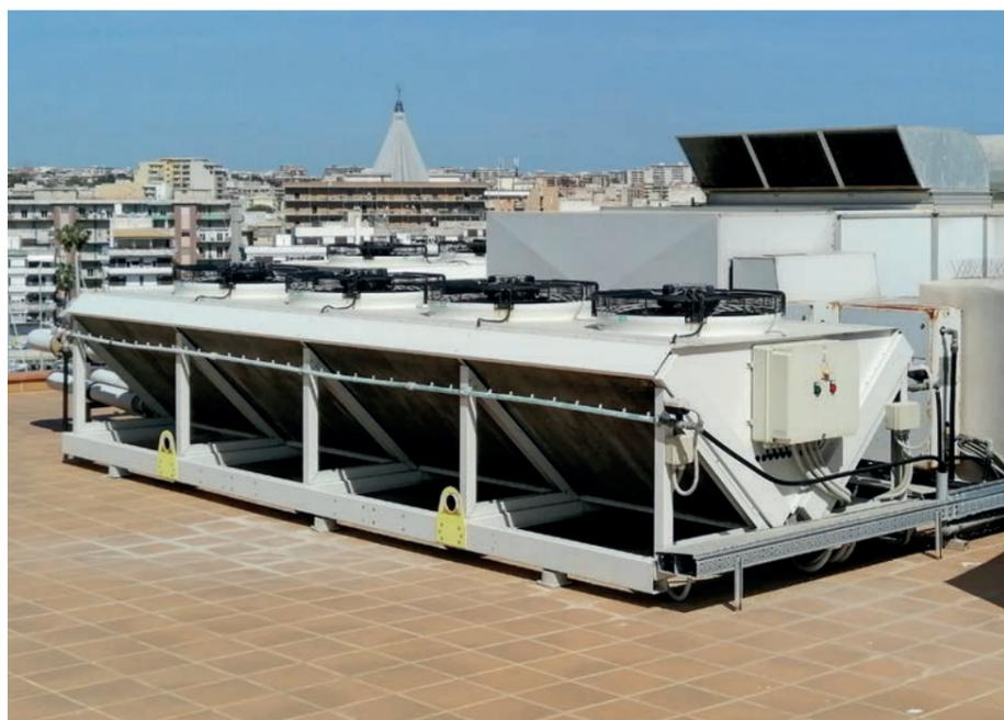
Il dry cooler e la UTA per l'aria primaria nelle camere sono poste in copertuta per una ottimale integrazione edificio-impianto.
