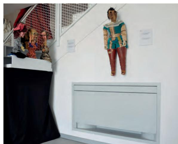
In alto. Produzione pittorica di Dario Fo. La sala è climatizzata da un ventilconvettore opportunamente incassato nel sistema "Ventilcassaforma".
