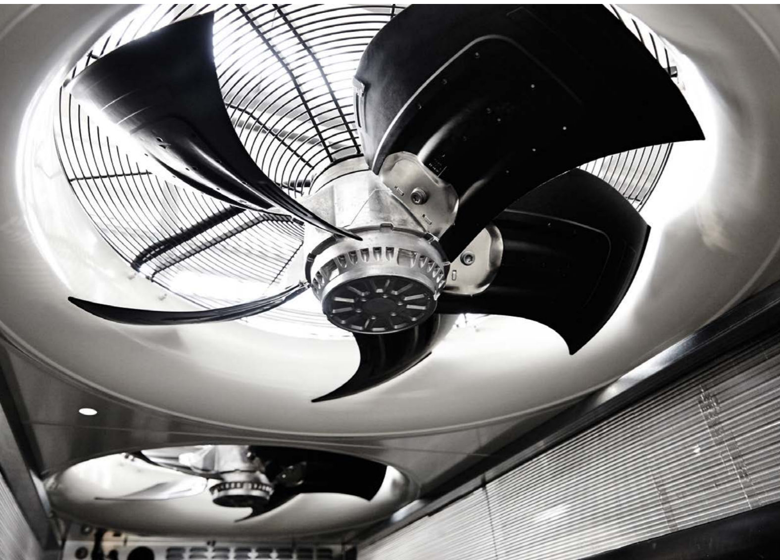
Ventiladores de última generación en una enfriadora Aermec
