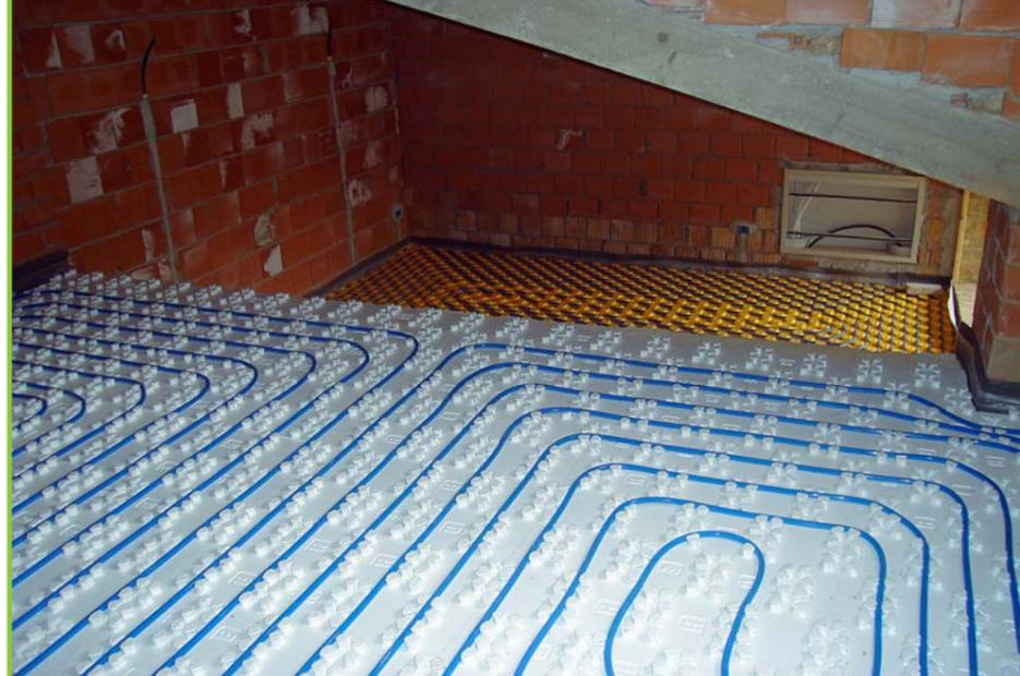
Per riscaldare e raffrescare la struttura la scelta progettuale è stata la realizzazione di due impianti completamente sovrapposti: impianto radiante a pavimento e integrazione con un impianto di riscaldamento, raffrescamento e deumidificazione con ventilconvettori a incasso. Sono stati anche installati otto collettori solari per la produzione di acqua calda sanitaria.
