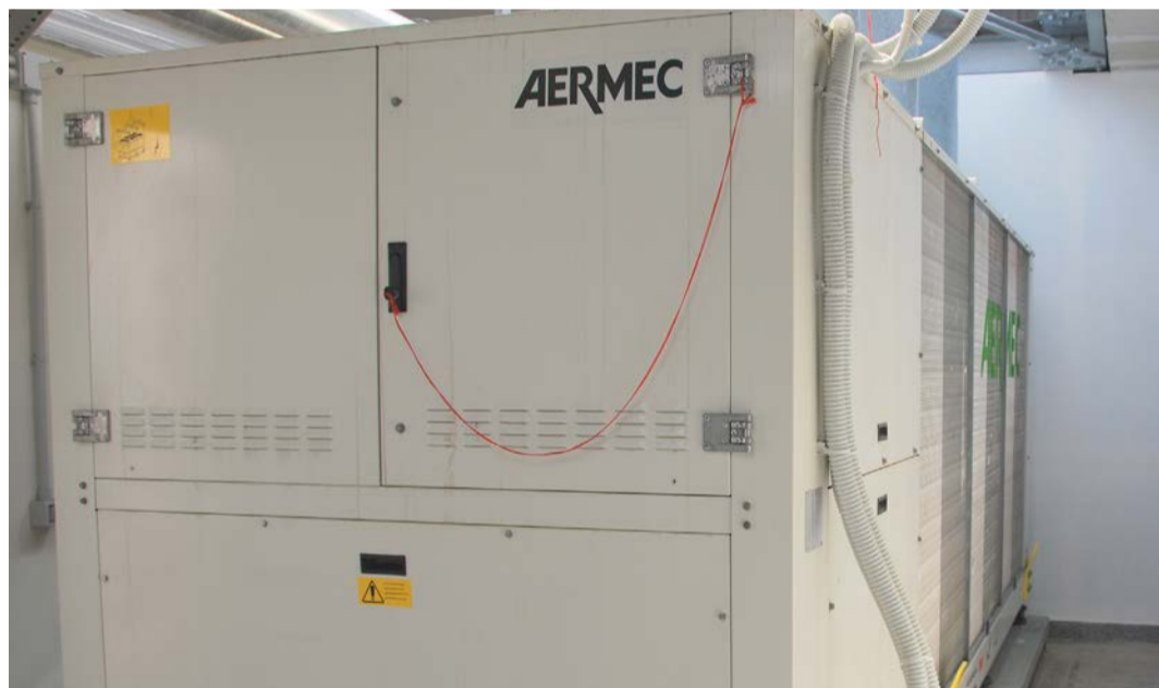
A lato: particolare del refrigeratore collocato in un apposito vano ventilato posto in copertura. Sotto: schema generale dell'impianto idronico.
